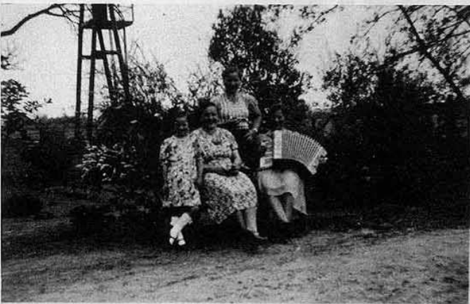
Käthe Freitag mit zwei Schwestern u. Nichte Waltraut. Im Hintergrund ein Mast mit Transformator. (Kobbelkampe 5/4)
