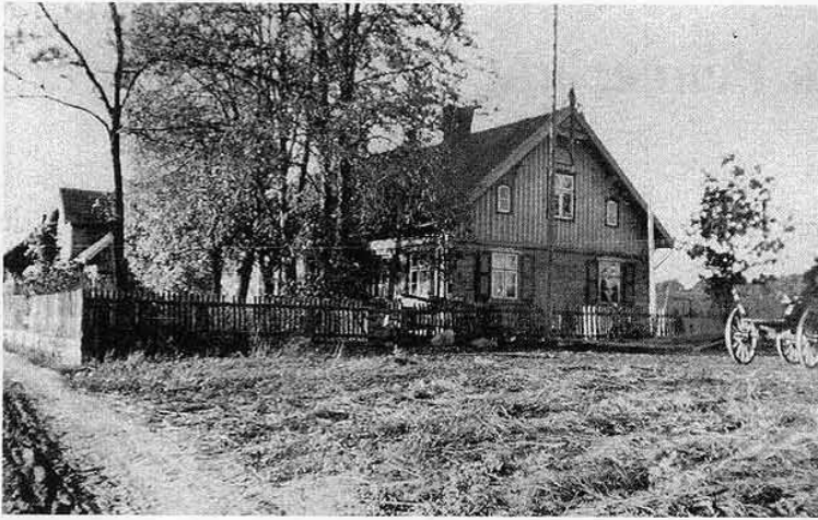
Wohnhaus Johann Rathke. Sägewerk u. Baugeschäft. (Pillauer Str. 27/1)
