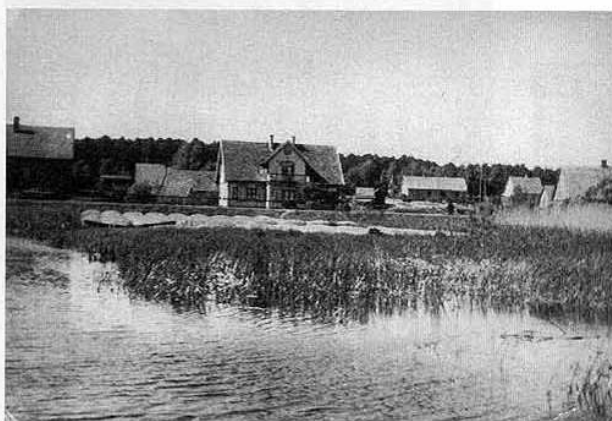
Bodenwinkel, Haffufer. V. l.: Bäckerei Conrad Radtke, daneben Hermann Gnoyke. Doppelhaus im Hintergrund: Johann Lobach/Gustav Klein, daneben Hermann Ott. Im Vordergrund, halb: Gustav Hübert. (Bodenwinkel 13/1)
