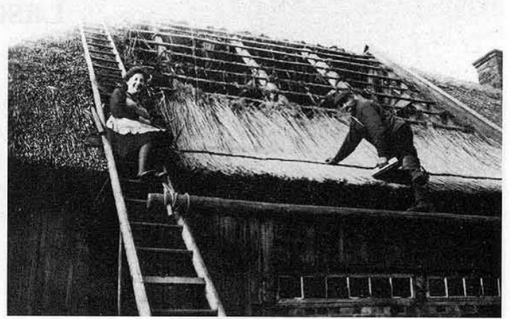
Bei Arthur Freitag, Kobbelkampe. Käthe Freitag u. Dachdecker Heinath auf dem Stalldach im März 1943. (Kobbelkampe 5/7)
