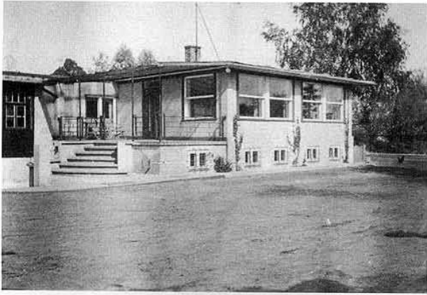
Stutthof. Maschinenfabrik Gerhard Epp. Bürogebäude, Eingang Hofseite. Zufahrt von der Straße zur Weichelbrücke am Milchgraben vorbei. (Danziger Str. 66/2)
