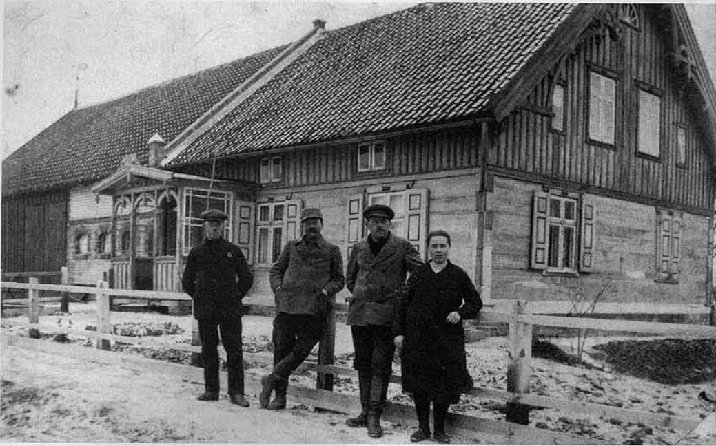
Wohnhaus Bootsbauer Heinrich Schmidt, 1930. Rechts: Heinrich u. Meta Schmidt. (Mittelhaken 8/2)
