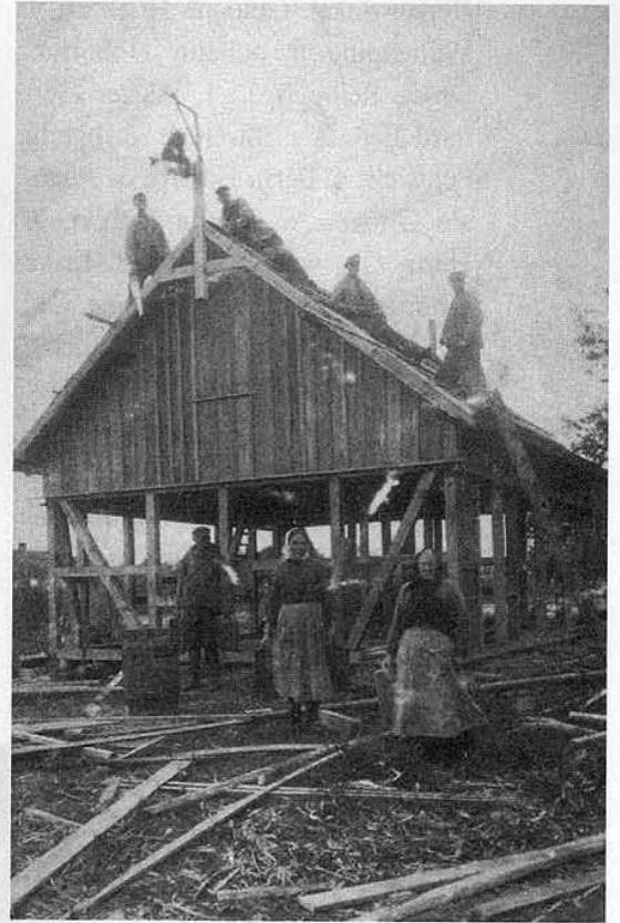
Wohnhaus im Rohbau 1932-33 von Rudolf Hübert. (Bodenwinkel 6/2)
