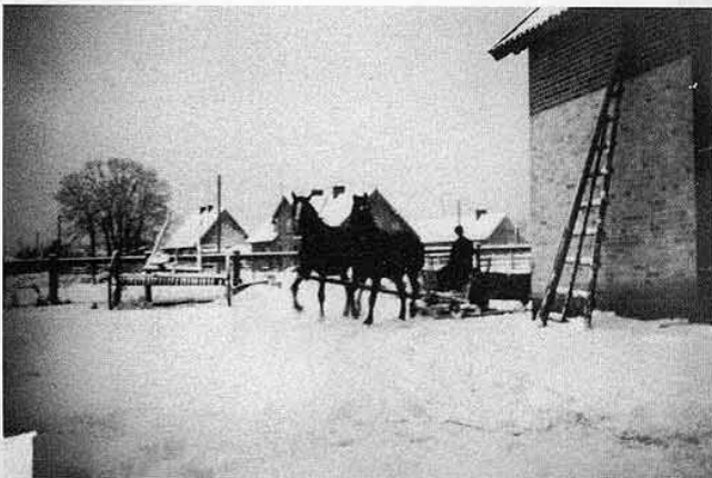
Hof v. Julius Freitag I, Pillauer Str. 31. Hinter den Pferden das frühere Gemeindehaus, links daneben: Trautmann/Duwensee. (Im Winter 2/3)
