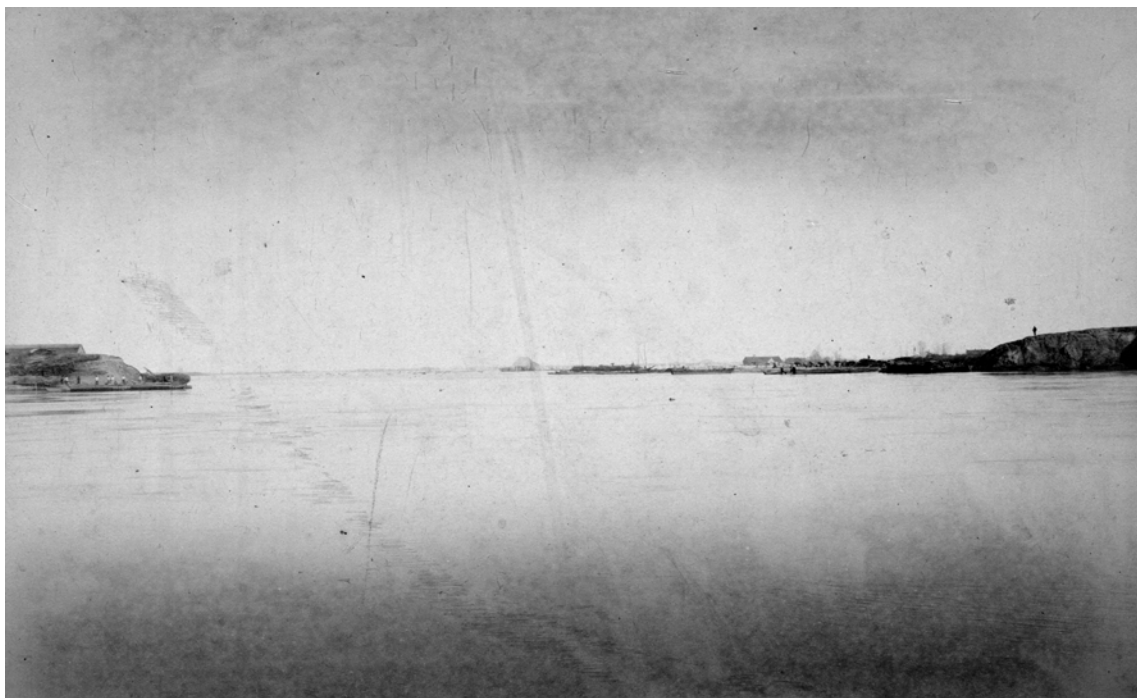
Dammbruch bei Jonasdorf - Blick in die überschwemmte Niederung
