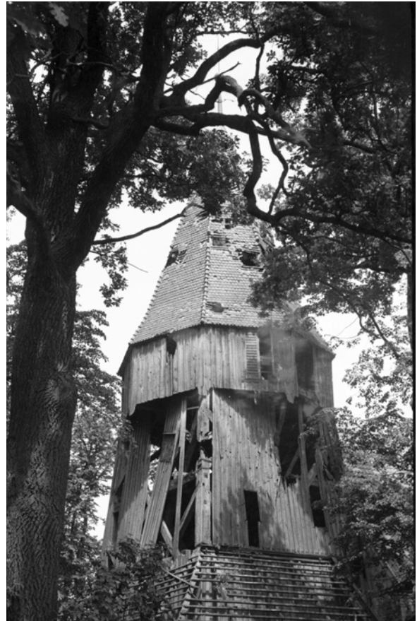
Der zerschossene Glockenturm
