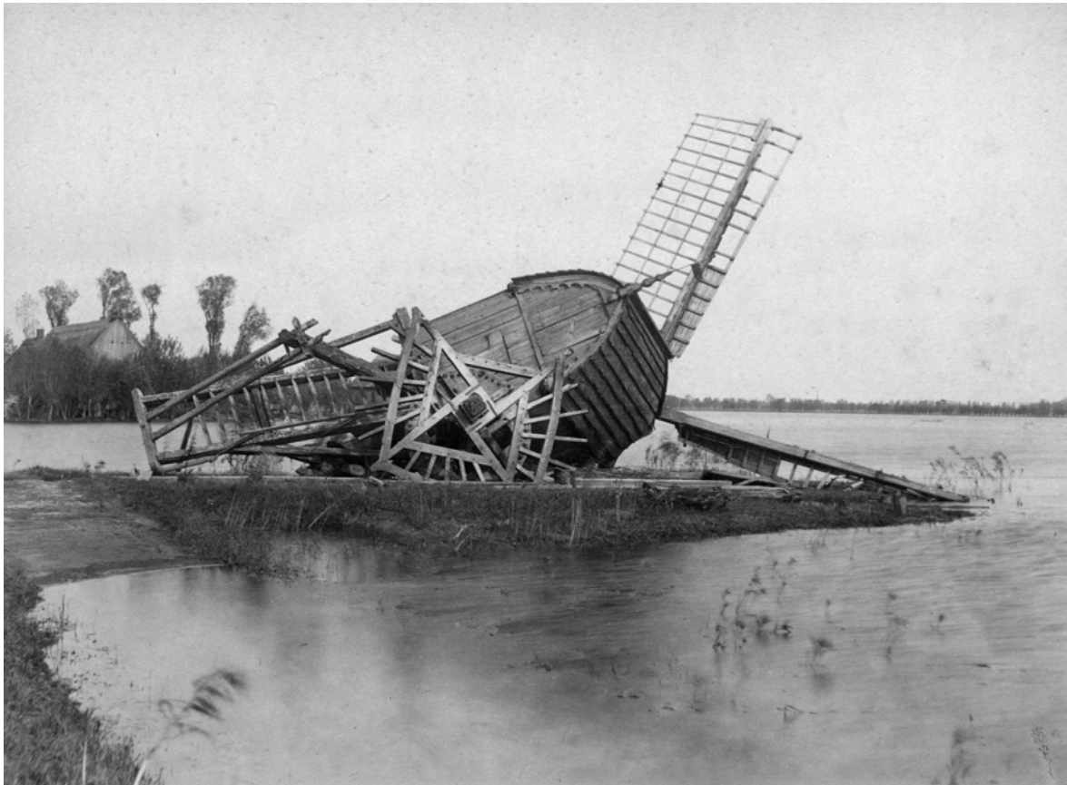
Einsturz der Entwässerungsmühle zu Möskenberg während der Überschwemmung
