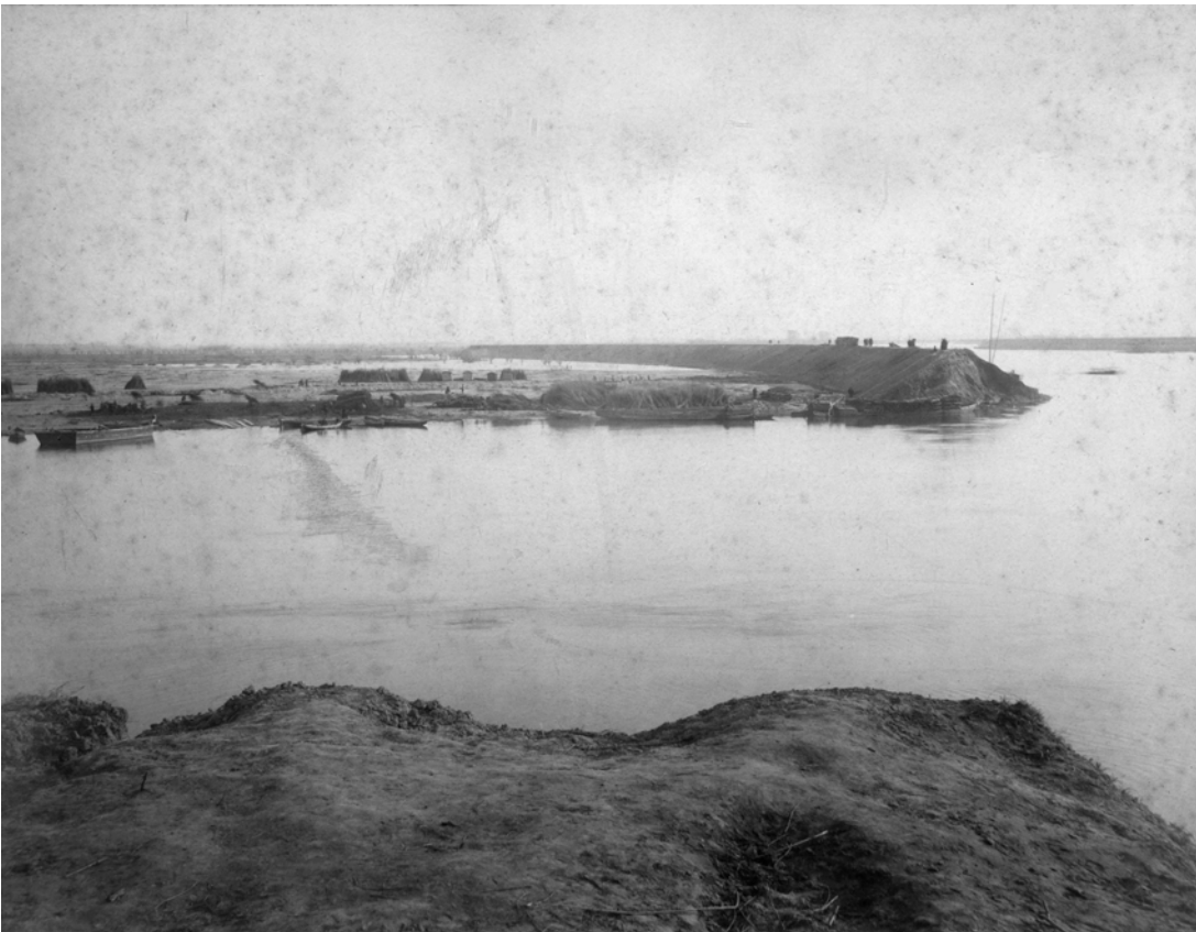
Dambruch bei Jonasdorf - südlicher Bruchkopf mit Versandung
