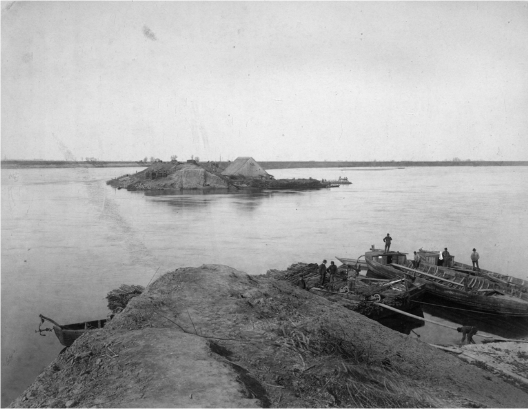
Dambruch bei Jonasdorf - nördlicher Bruchkopf
