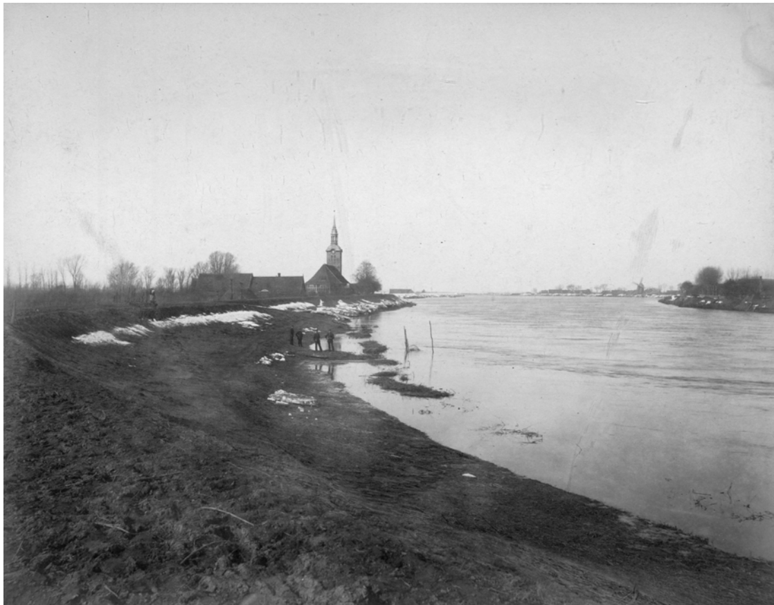
Dambruch bei Jonasdorf - Zeyer
