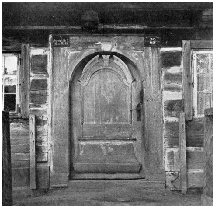
Tür der 1924 abgebrannten Schule
