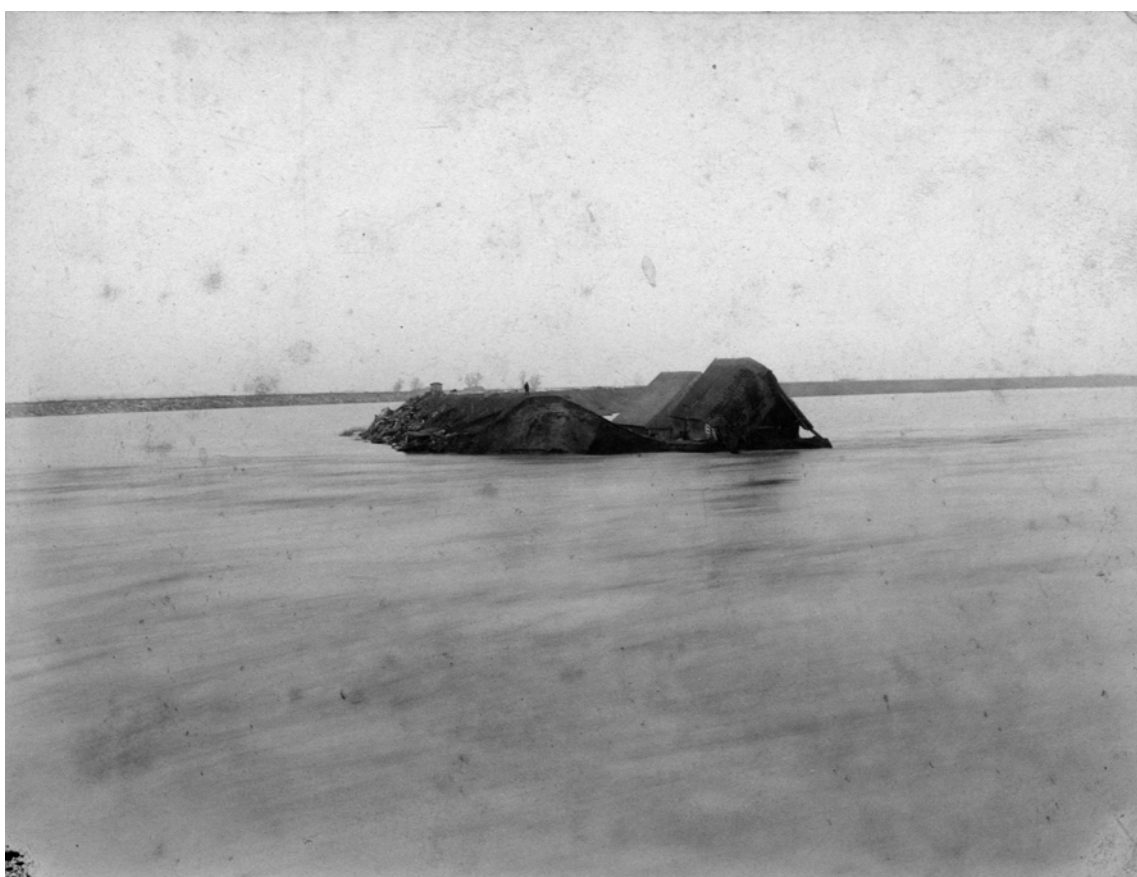
Dammbruchstelle unterhalb von Jonasdorf mit der zertrümmerten Lau'schen Wachbude - im Hintergrund links der Gr. Werder Nogatdamm
