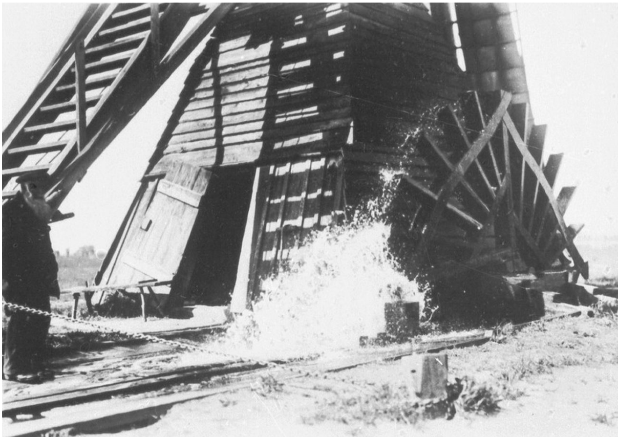
Wassermühle im Danziger Werder mit sog. Wurfrad
