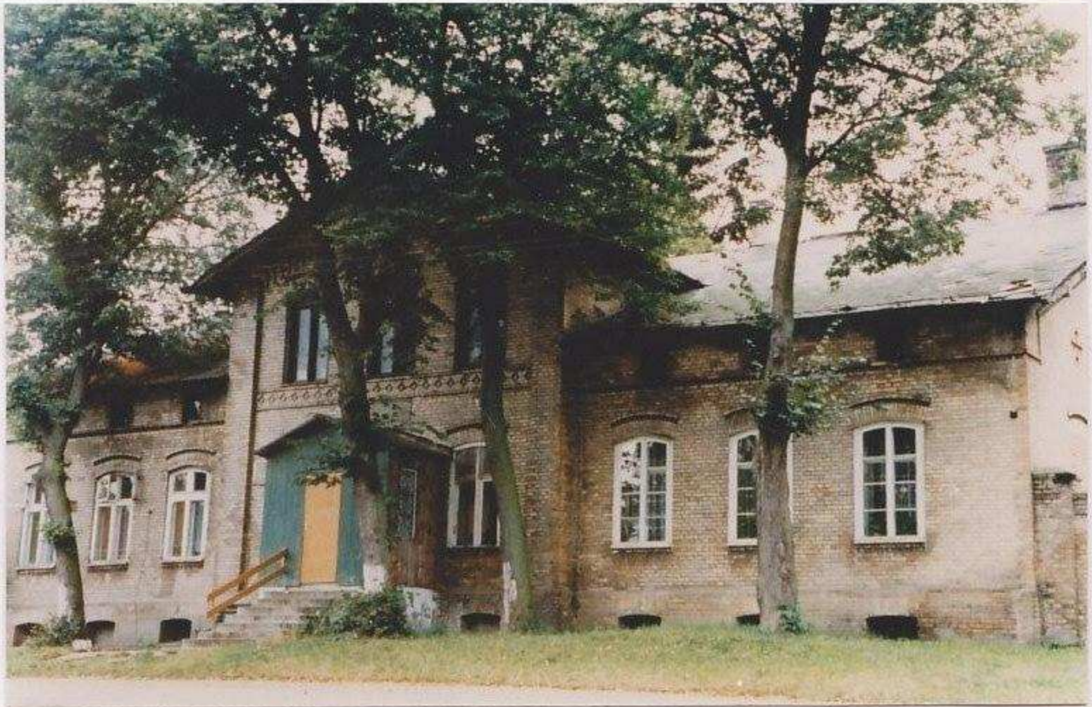
Gutshaus des Max Doerksen zu Groß-Zünder Aufn. 1991, ein Klinkermauerwerk das unter polnischen Denkmalschutz gestellt wurde. Es fehlt der verglaste Vorbau.
