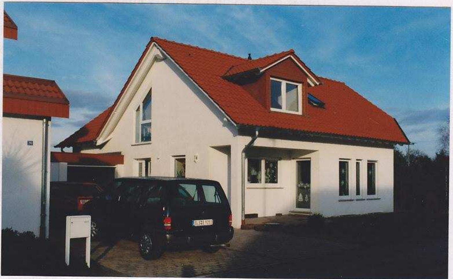
Wohnhaus des Klaus Wannow in St. Ingbert / Saarland
