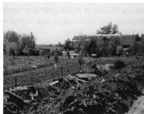
Hintergebäude der Käserei Beck, 1994. (Grenzdorf A, 2/2)
