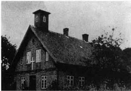
Katholische Kapelle in Stutthof. (Schulstr. 7/1A)
