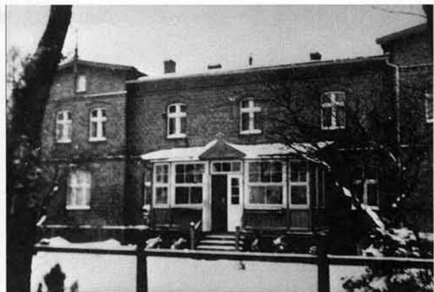
Zolldienstgebäude in Steegen. (Zoll 1/1)
