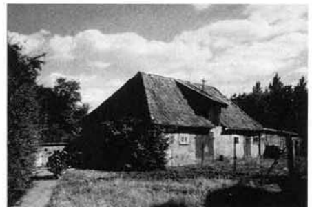
Toilettengebäude mit Garage für Lehrer der Schule Groschkenkampe 1996. (Groschkenkampe 2/3)
